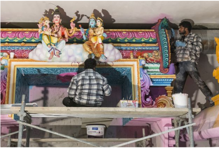
Bau des Hindutempels im Haus der Religionen im Jahr 2014. Foto: Keystone
